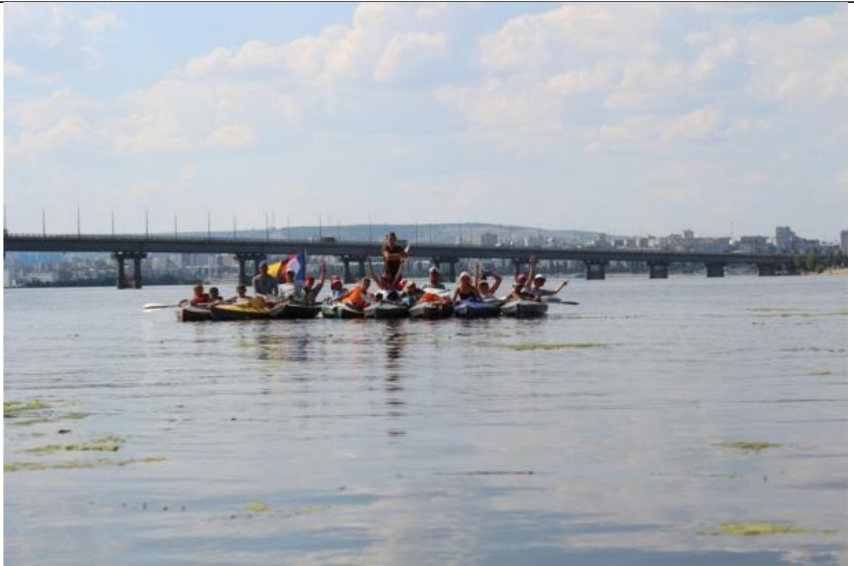
Автомобильный мост «Саратов-Энгельс»
